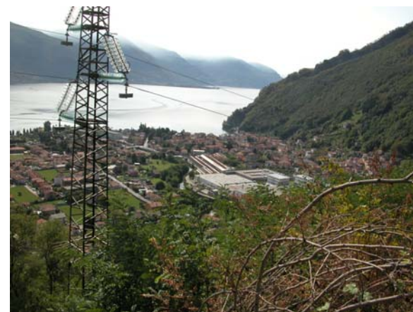
Viste panoramiche dalla strada per Catasco
